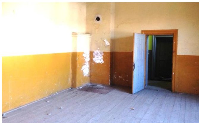
Fotos: Ungenutzter Raum vor der Renovierung / Renovierungsarbeiten:
